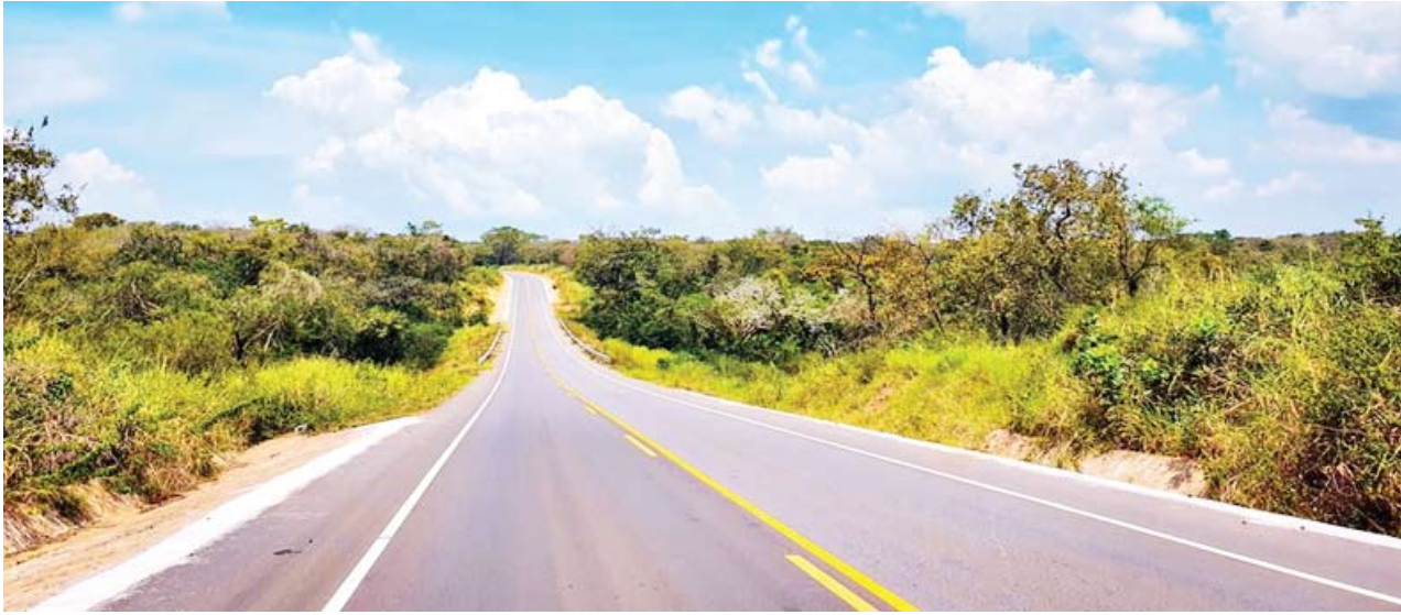
Hoima-Butiaba-Wanseko Road (111 Km)
